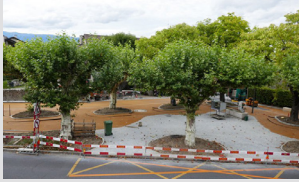
Illustrations 7 : Place de la Mairie, phase finale du chantier, juillet 2017 Source: Commune de Perly-Certoux
