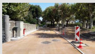
Illustration 5.8 : Mise en place Zone 20, chemin du village-de-Perly Source: CITEC Ingénieurs Conseils
