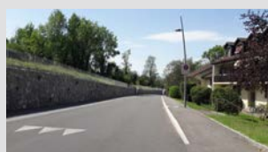
Illustrations 5.16 et 5.17 : Nouvel aménagement cyclable sur la route de Certoux direction Perly et direction Certoux Sources : Citec Ingénieurs Conseils
